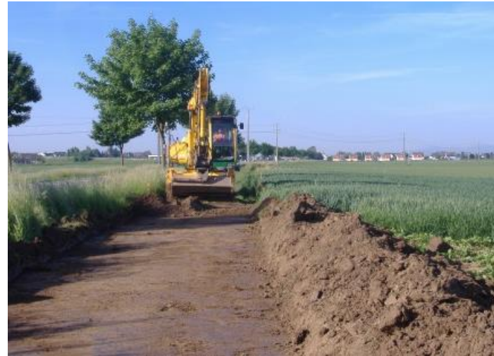
Terre végétale décapée des milieux agricoles
