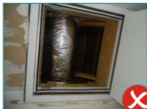
1 : Trappe mal positionnée par rapport aux conduits (accès bloqué par le conduit)
