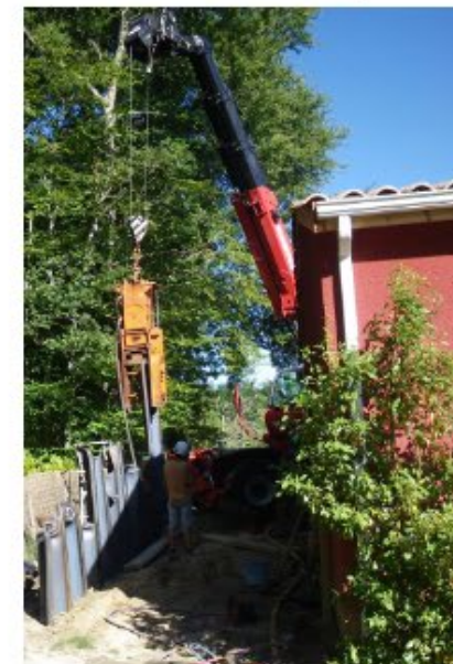
Ecran palplanches métalliques Maison rouge
