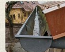
4 Nettoyer les gouttières
