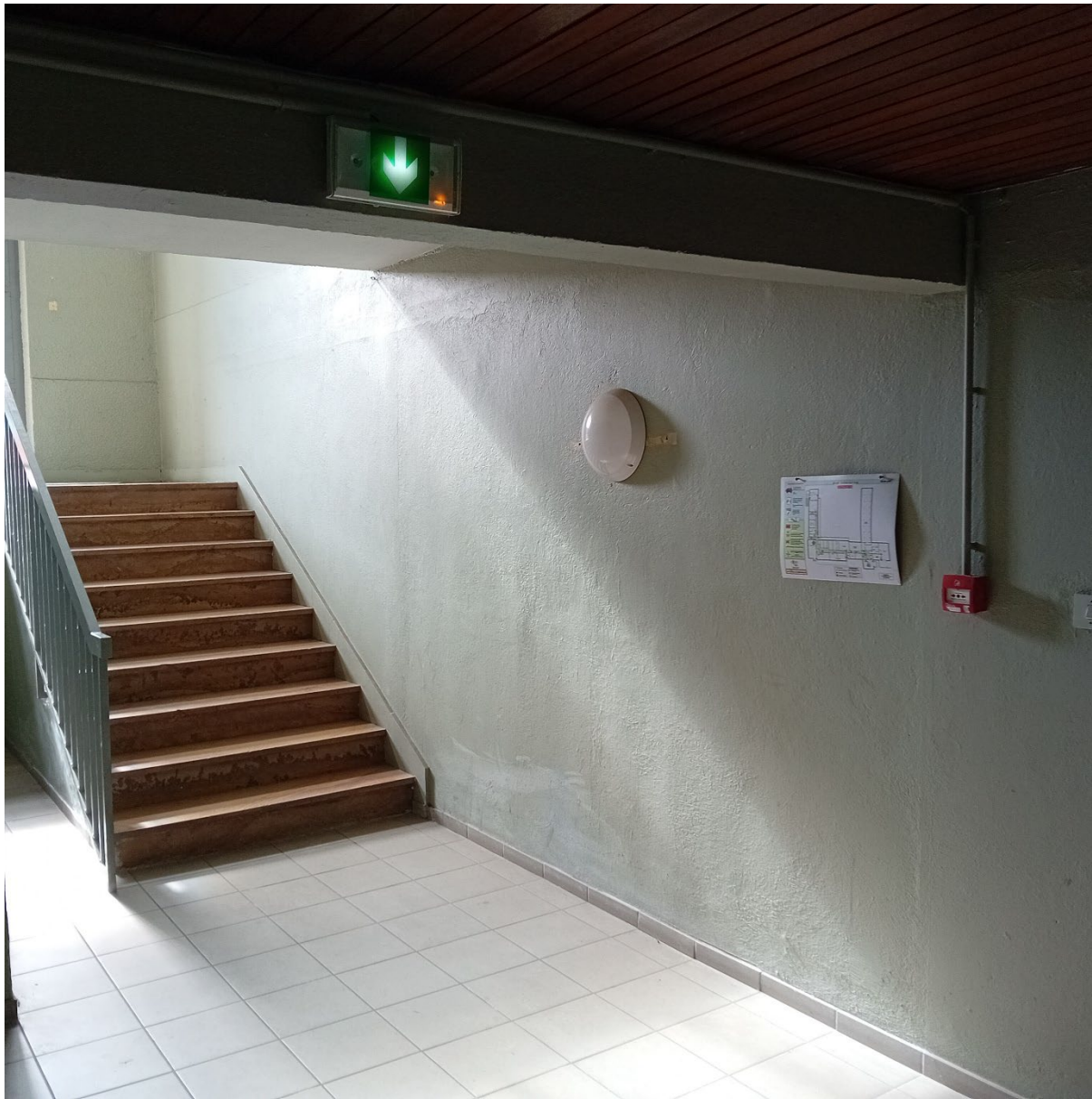
Escalier vers sous-sol
