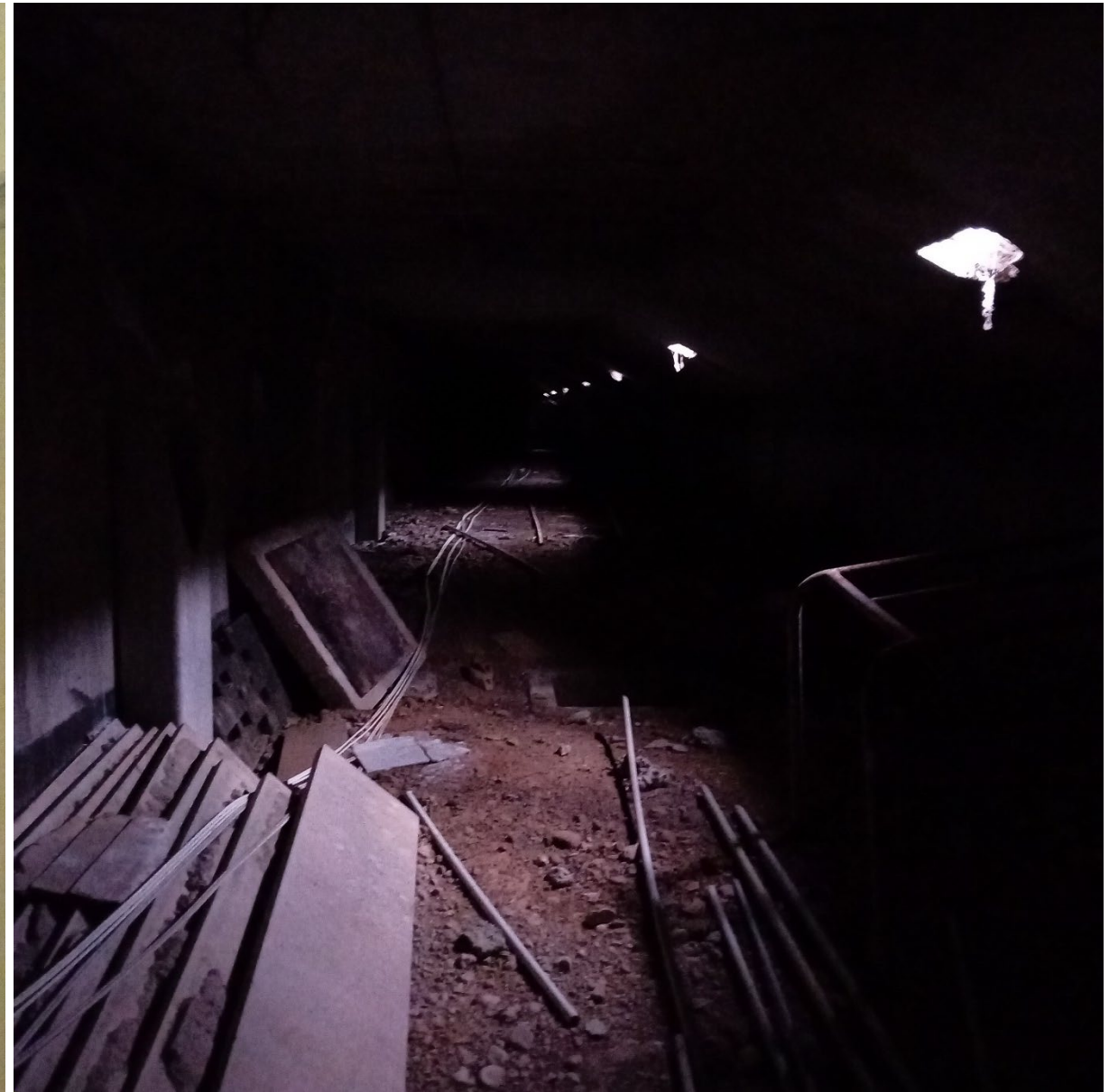
Vide sanitaire sous-sol ( dessous les escalier)
