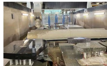
Espace des commandes numériques
