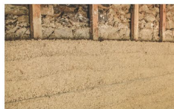
Béton de chanvre : mélange chaux chanvre
