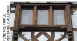
Baie à meneaux
