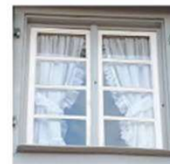
CARREAU: feuille de verre plate soufflée en manchon VITRAGE ASSEMBLE avec des PETITS BOIS + MASTIC
