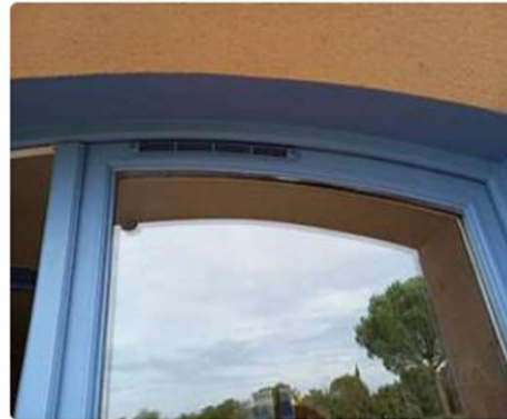
Des entrées d'air au niveau des menuiseries
