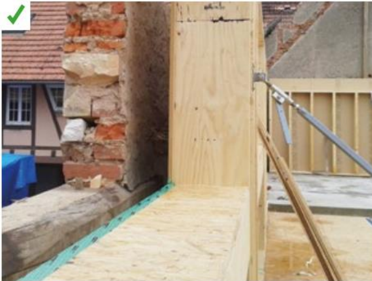
Dans un bâtiment existant très vétuste et afin d'atteindre un niveau de performance élevé, mise en œuvre d'une nouvelle enveloppe ossature bois préfabriquée en atelier à l'intérieur de l'ancienne enveloppe en brique.
