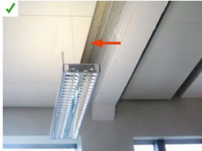
Dans cet immeuble industriel des années 30, les murs ont été isolés par l'intérieur. Des panneaux d'isolant à base de fibres végétales ont été posés sur la périphérie en sous-face du plancher haut. ©AQC
