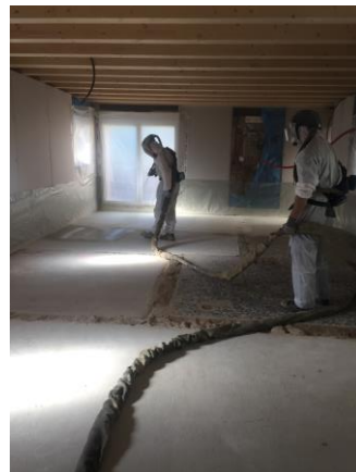
Traitement thermique du soubassement du mur par l'intérieur au moyen d'une dalle en béton de chaux-pouzzolane. Celle-ci repose sur un hérisson sur drain ventilé. ©AQC
