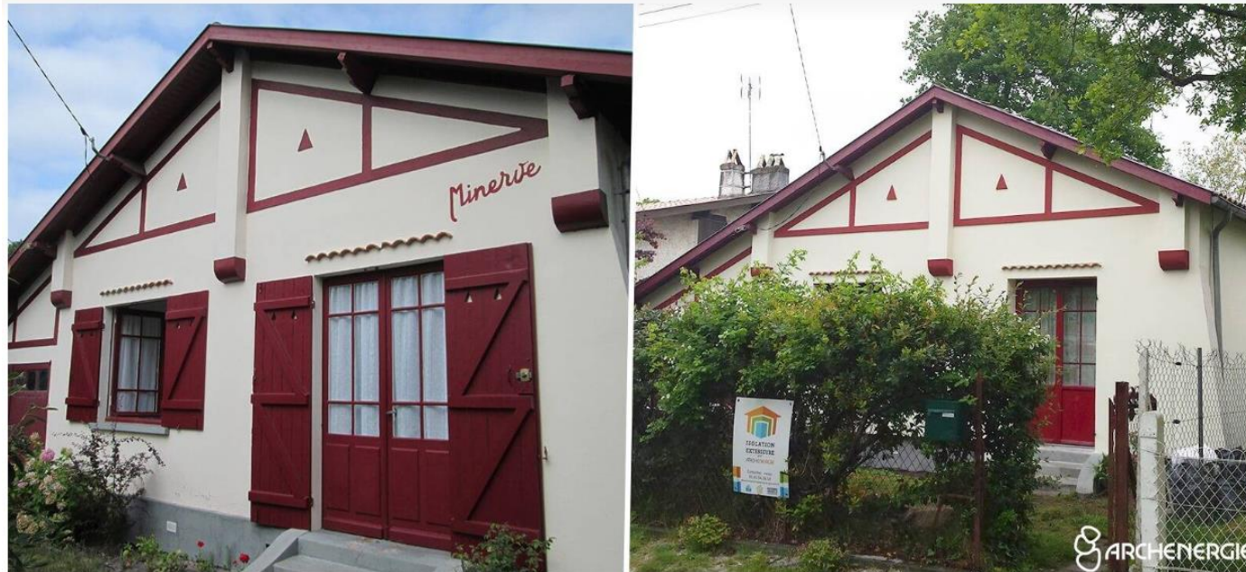
Maison typique des années 50 à Andernos (33). Avant travaux (photo à gauche). Après travaux d'isolation extérieure en polystyrène (photo à droite). © ARCHENERGIE
