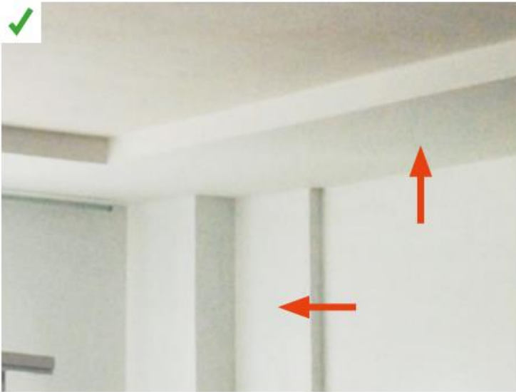
Un retour d'isolant sur 100 cm a été réalisé sur le contour du plancher haut et à l'intersection du mur de refend avec le mur extérieur. ©AQC
