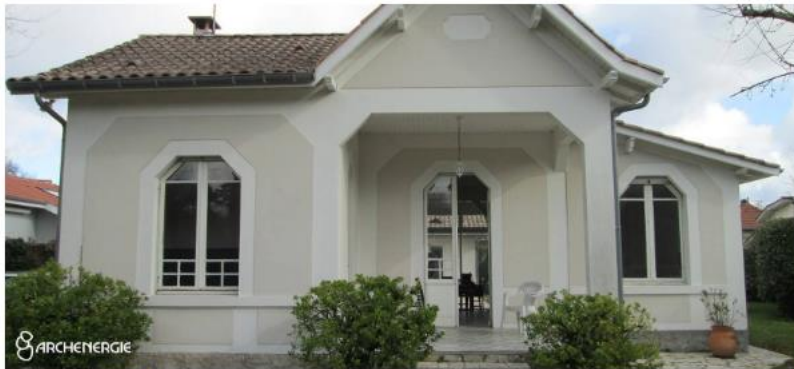
AVANT RÉNOVATION : Maison style arcachonnaise à Arès (33) © ARCHENERGIE
