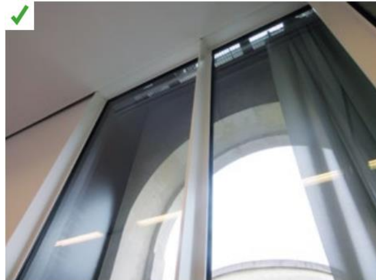
Réalisation d'une nouvelle enveloppe en ossature poteau-poutre métallique en retrait de la façade en pierre. L'espace entre les parois a permis d'insérer des brises-soleil motorisés. ©AQC
