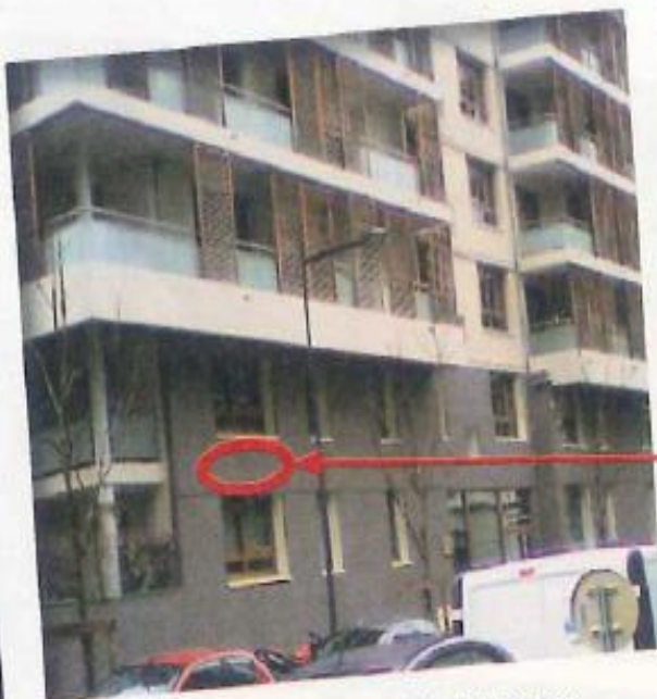
Livré en 2008, le Patio Lumière (ZAC de Bonne, Grenoble) visait 42,5 kWh/m 2 hab.an en chauffage. Il consomme en réalité 32 % de plus.
