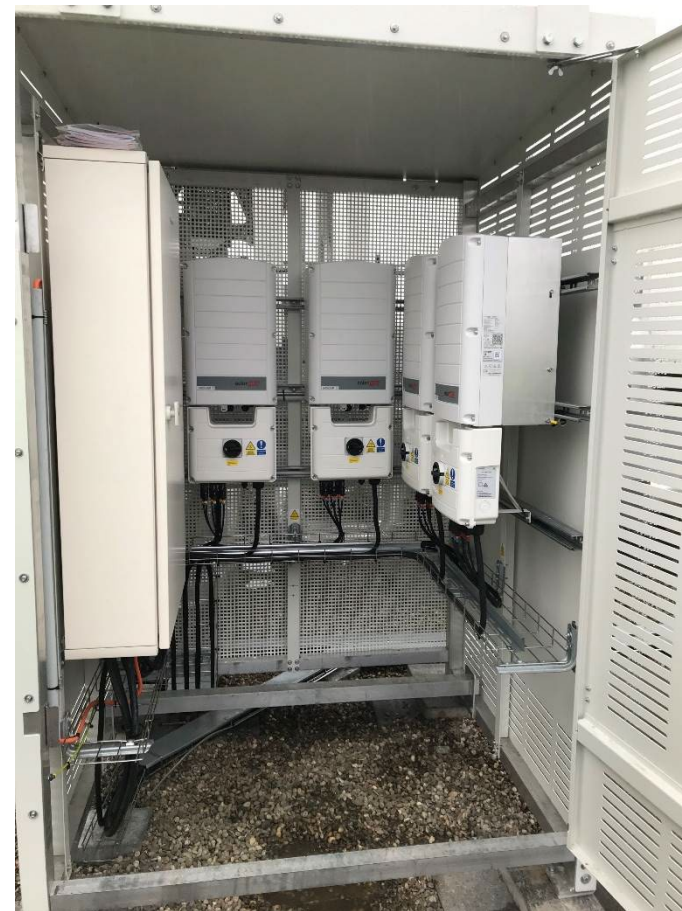
Shelter avec onduleurs et coffrets électriques
