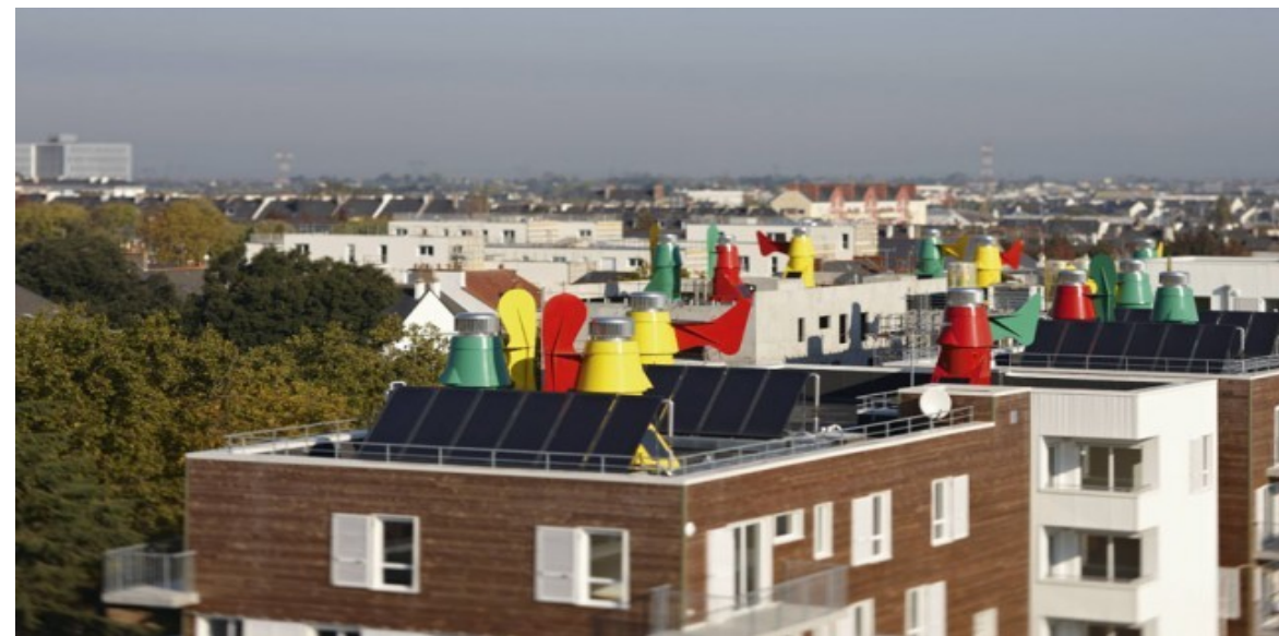
Saint-Nazaire : ventilation naturelle assistée et contrôlée
