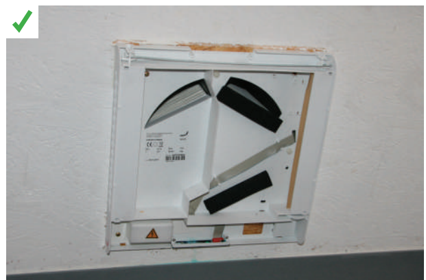
Pour limiter le temps d'intervention et donc les coûts, la maîtrise d'ouvrage a souhaité l'installation de modules dont l'accès aux filtres se fait par l'intérieur et avec le moins de manipulation possible. Ici, le démontage du capot intérieur se fait sans outils. ©AQC
