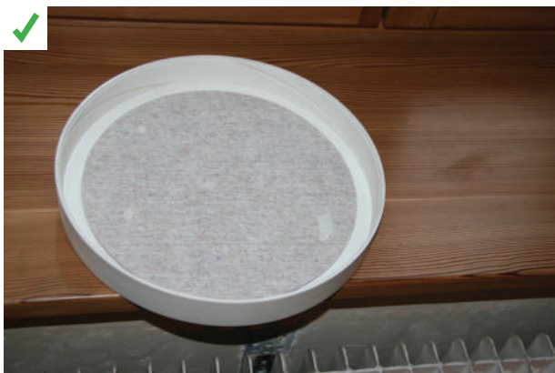
Mise en place d'un filtre acoustique à l'intérieur du capot de la bouche du module push-pull. Fourni par le fabricant, il permet une atténuation du bruit extérieur de 2dBA sans modifier les débits d'air. ©AQC
