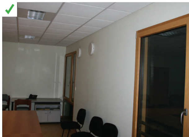
Ventilation double flux décentralisée implantée en hauteur dans la pièce. Le flux d'air est parallèle au mur de support. La diffusion de l'air neuf est optimisée par effet coanda, avec une vitesse de soufflage suffisante pour assurer un balayage complet de la pièce et sans gêne perceptible pour les usagers.
