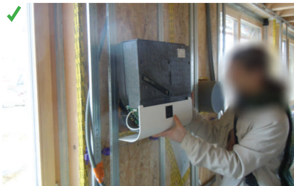
Ventilation double flux décentralisée installée à hauteur d'homme, facilement démontable et ne nécessitant pas d'outils ce qui simplifie l'entretien. ©AQC
