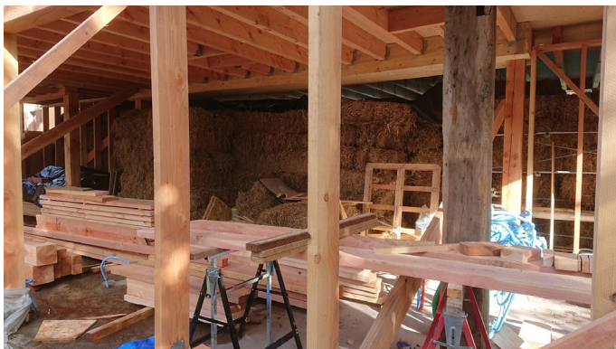
Visite de chantier de maison individuelle ossature bois/remplissage paille à Strasbourg avec l'Eurométropole de Strasbourg, 8 juin 2021, 24 participants.
