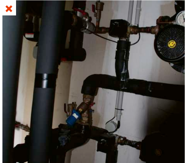
Absence d'indication (code couleur, étiquette, sens de circulation, etc.) des éléments du réseau. ©AQC
