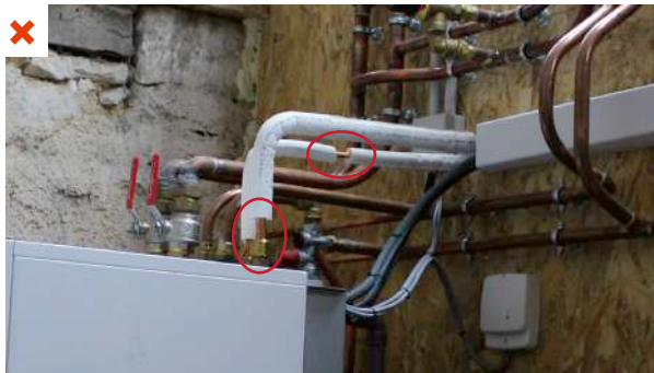
Isolation incomplète du réseau frigorifique. ©AQC
