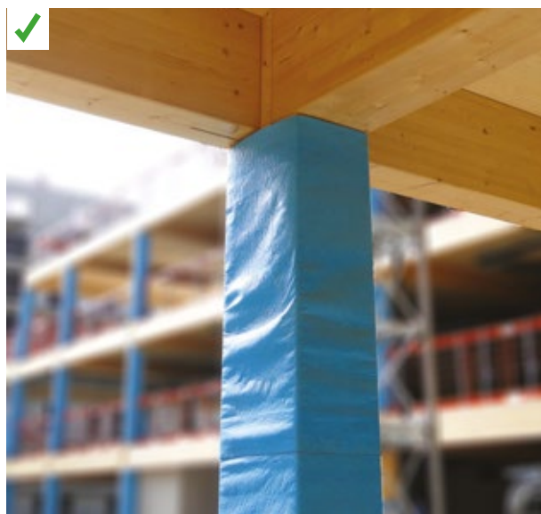
Les poteaux bois sont protégés contre les chocs
