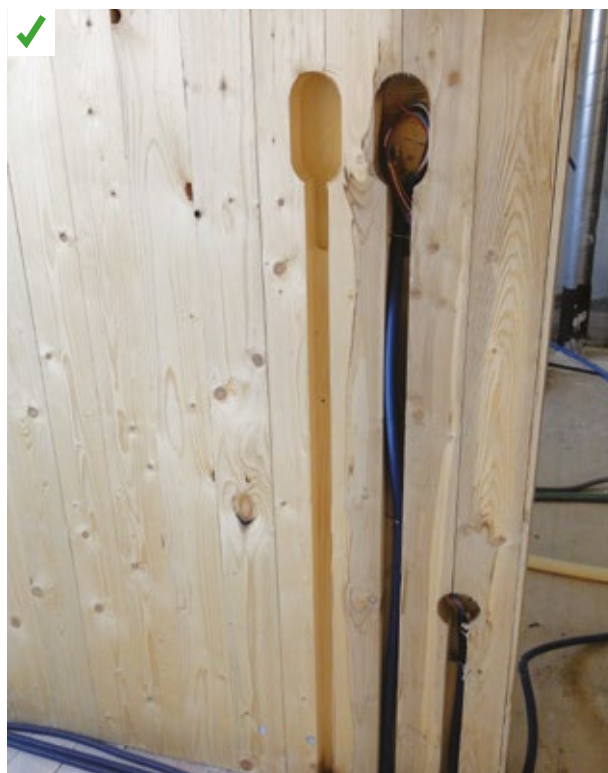
Les saignées pour le passage des câbles électriques ont été effectuées en atelier
