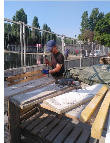
Chantier d'insertion au service du réemploi avec Travail et Vie. Déconstruction soignée - Préparation de la matière.
