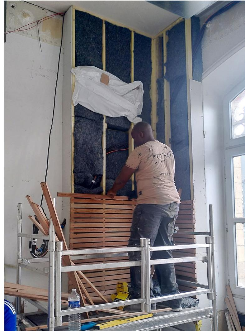
Isolation du rez-de-chaussée. Isolant fibres textiles recyclées biosourcés ; Lattis réemploi – enduit plâtre ; Soubassement panneaux MDF réemploi E15.
