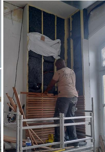
Isolation du rez-de-chaussée. Isolant fibres textiles recyclées biosourcés. Lattis réemploi – enduit plâtre. Soubassement panneaux MDF réemploi E115.
