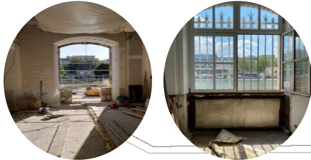
Conservation et redéploiement des fenêtres double vitrage existantes,
