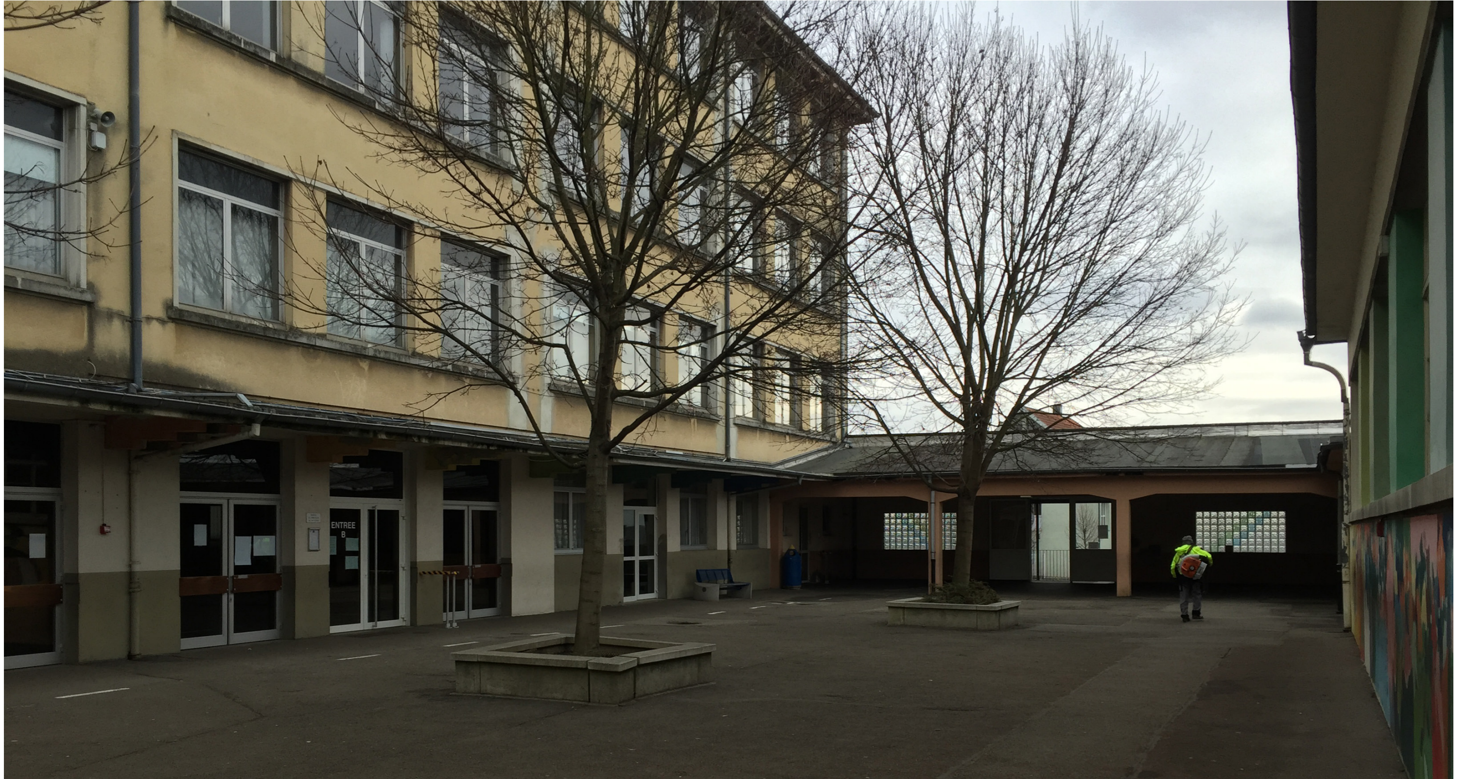
Avant : Façade en Surchauffe
