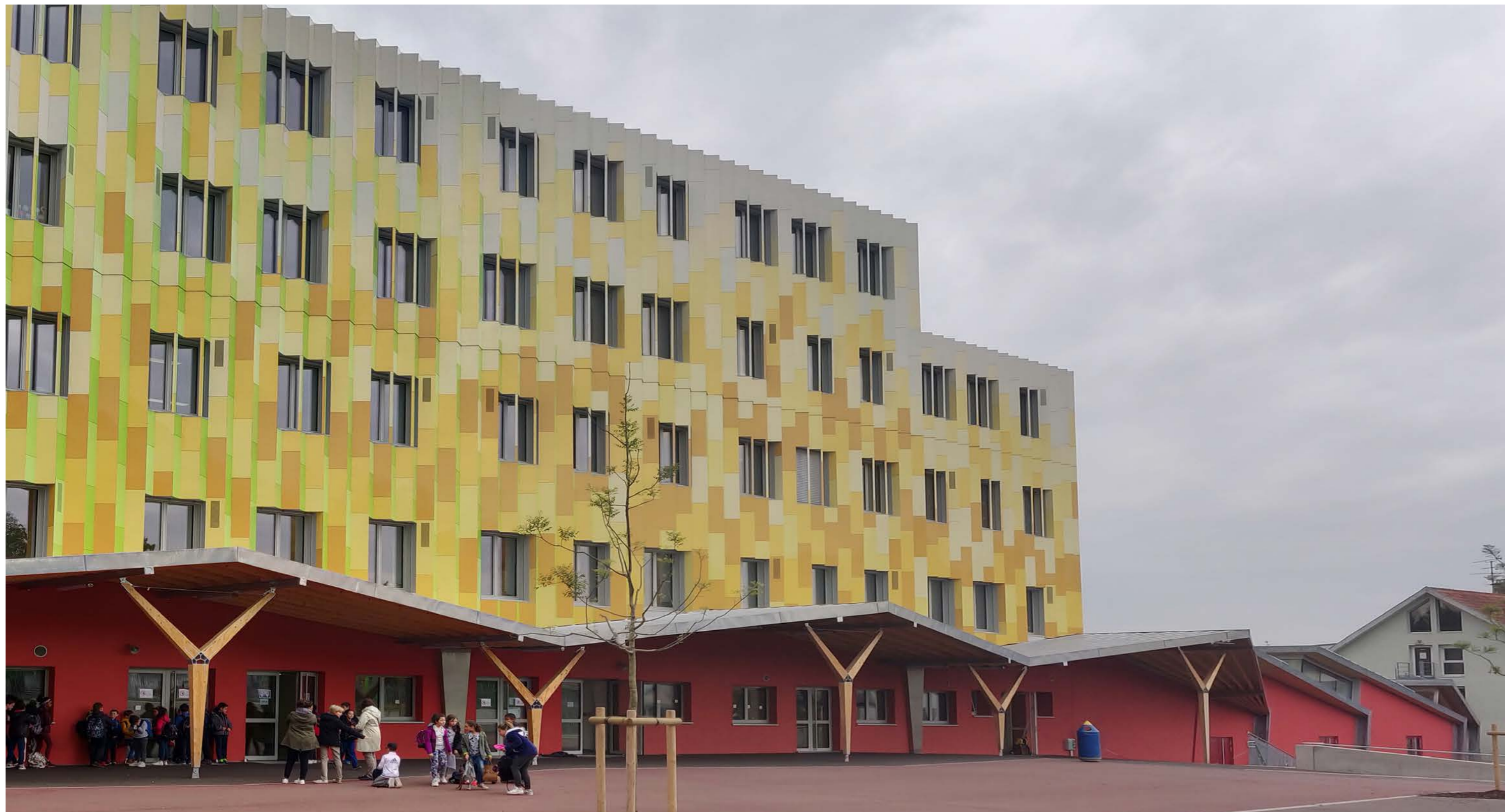
Après : Façade arrière
