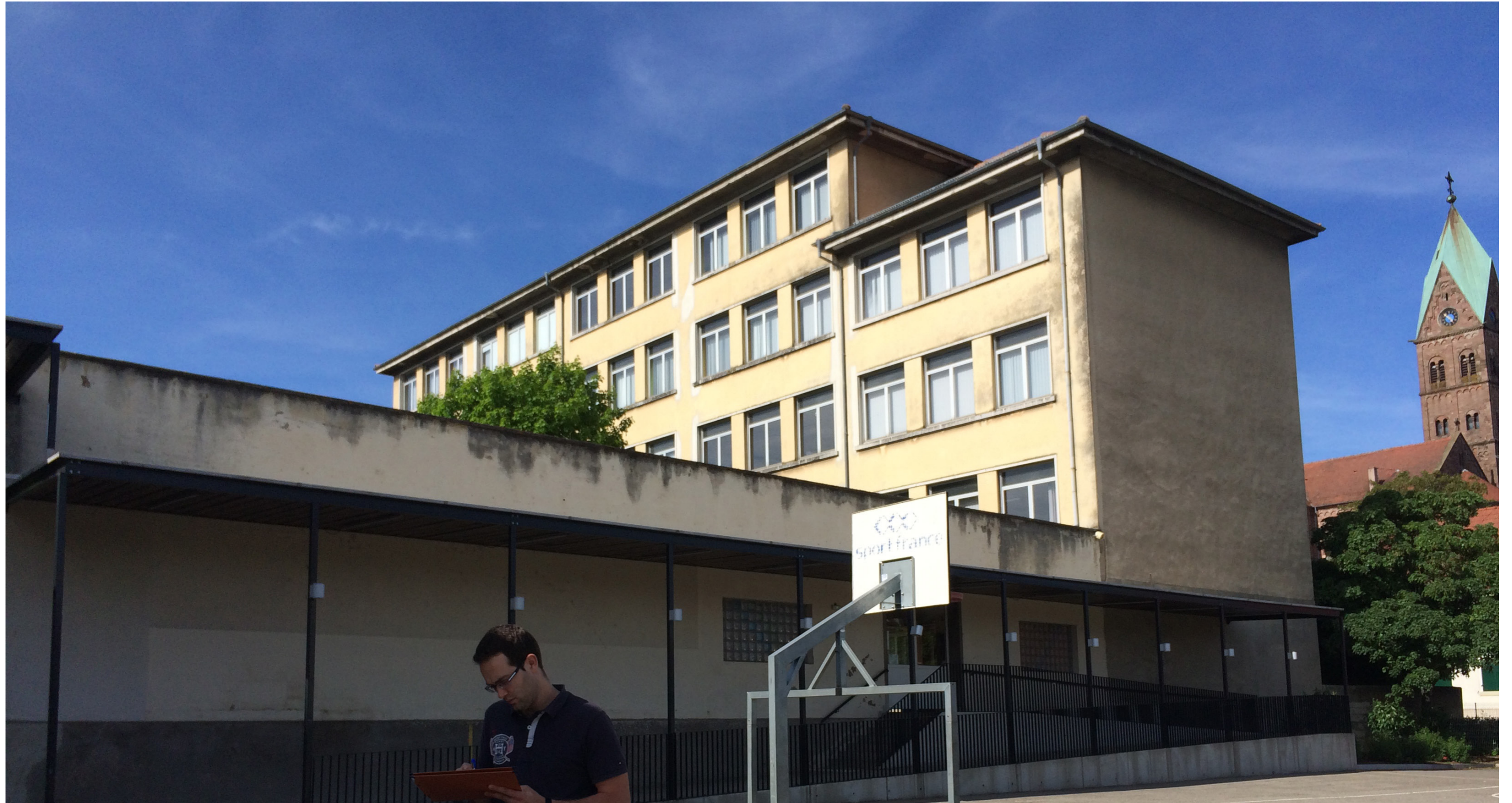
Avant : Façade en Surchauffe
