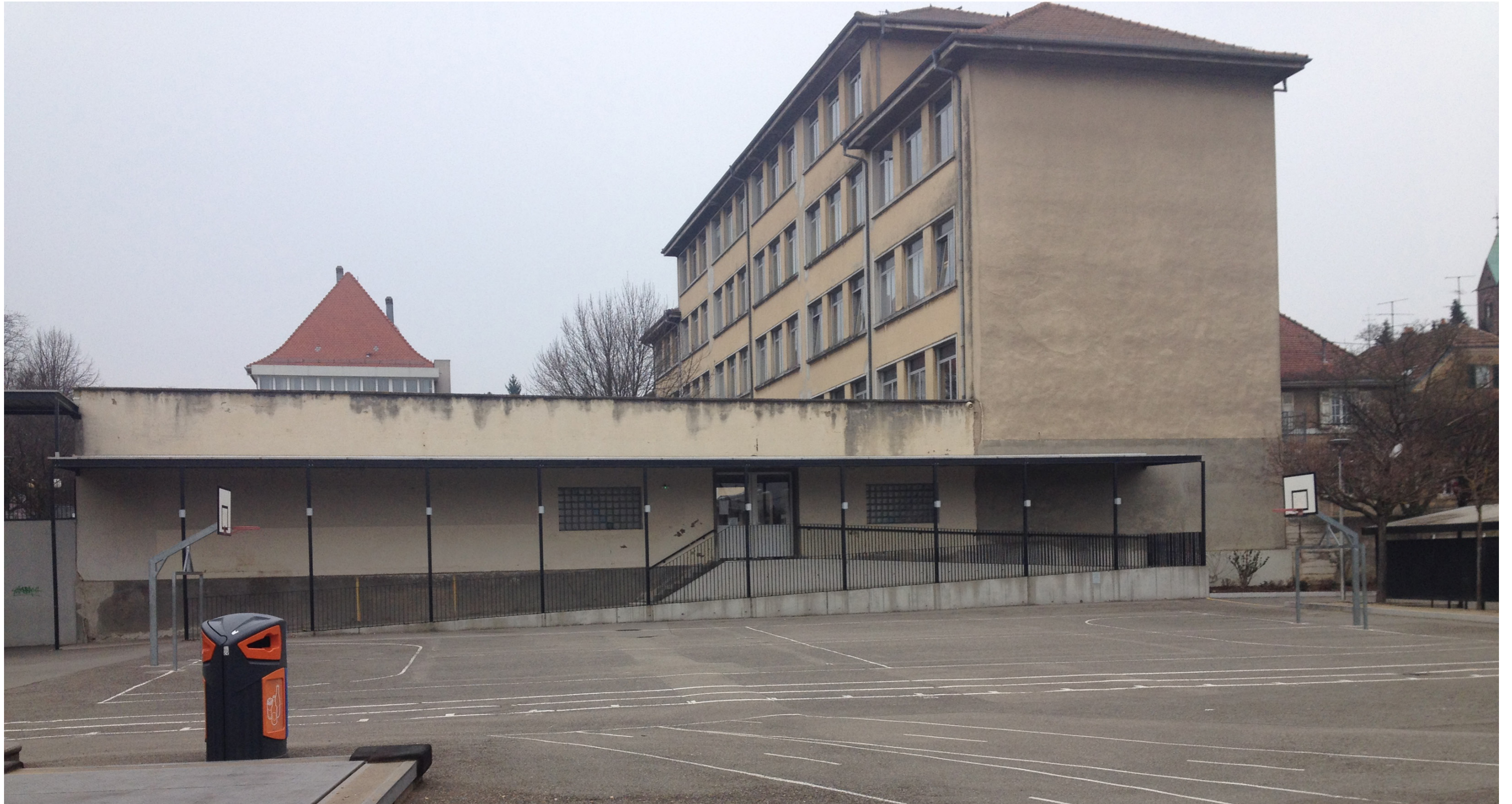
Avant : Façade en Surchauffe
