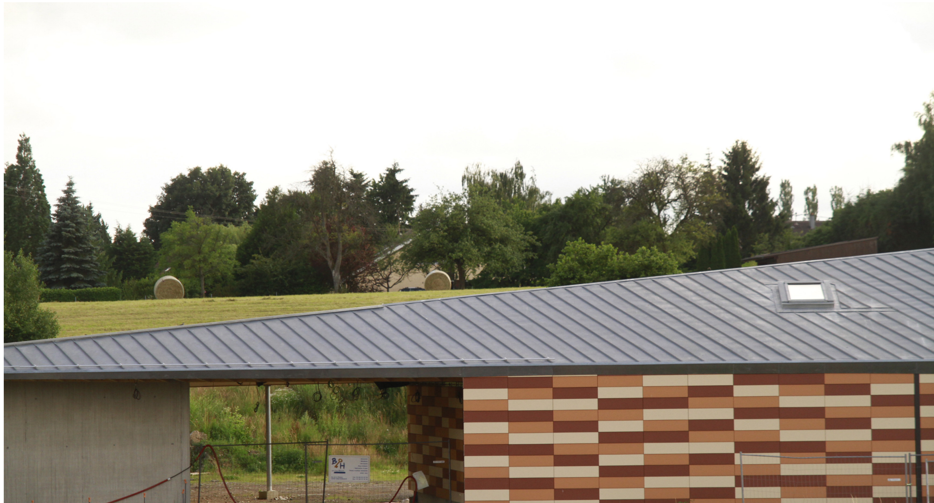
Vue Puit de lumière quadruple vitrage
