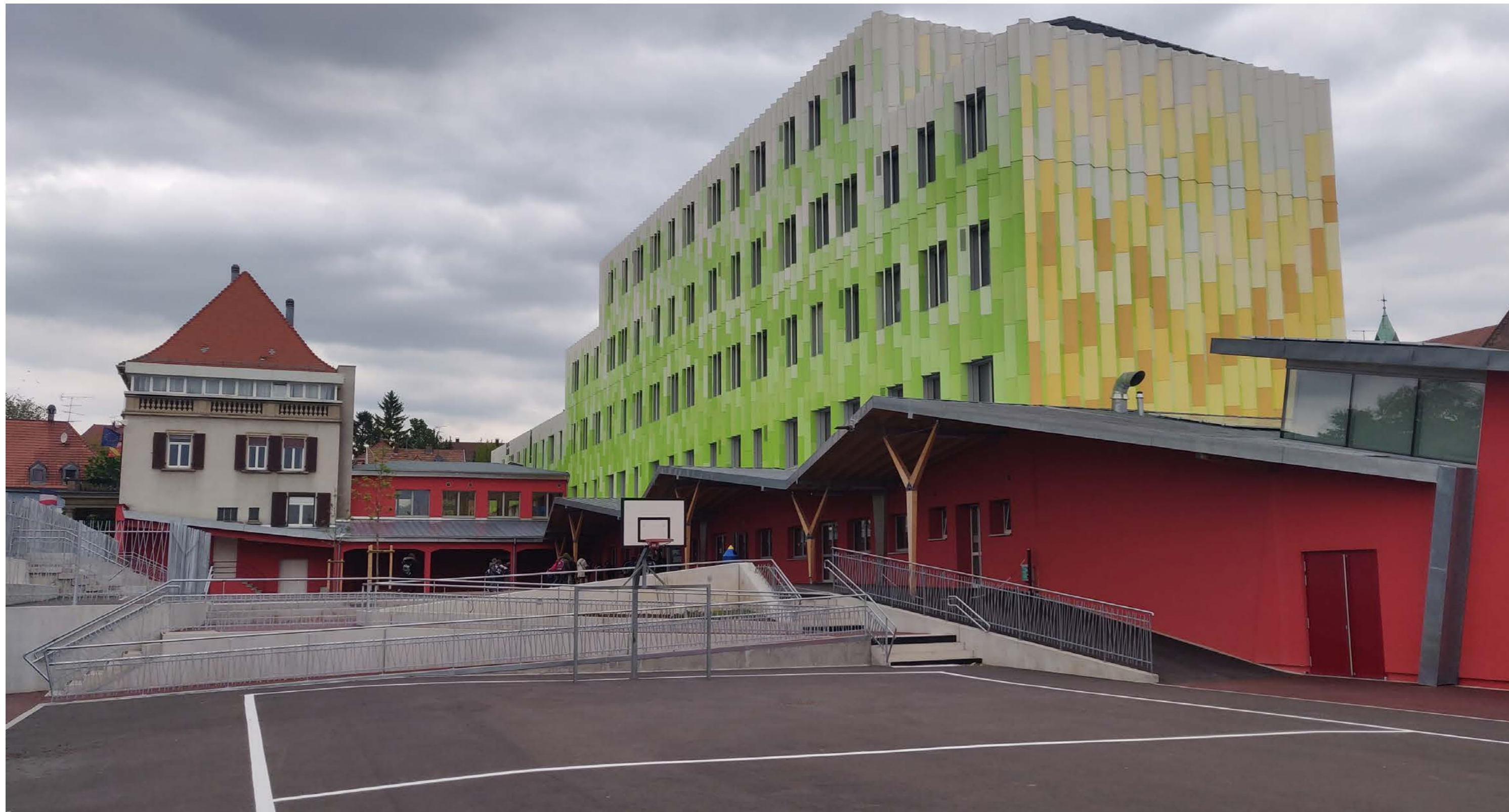
Après : Façade arrière
