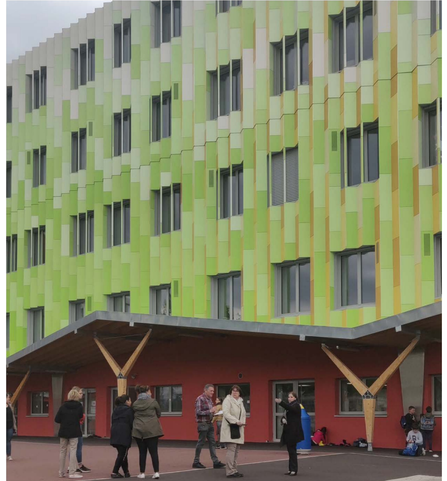
Intérieur avant - Protection solaire après
