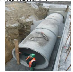
Des conduits d'assainissement en puits climatiques
