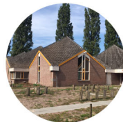
gelamineerd houten kniespanten St. Michielsgestel
